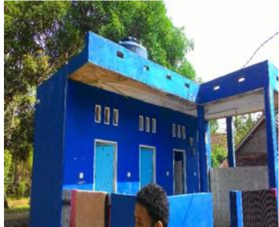
Gambar 9. Perbaikan dan perawatan MCK di Desa Tarumanegara
